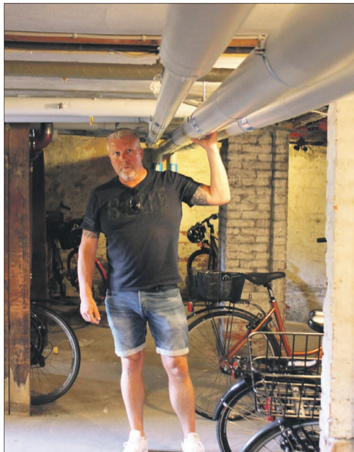
Nede i kælderen er der også trukket nye isolerede rør.
